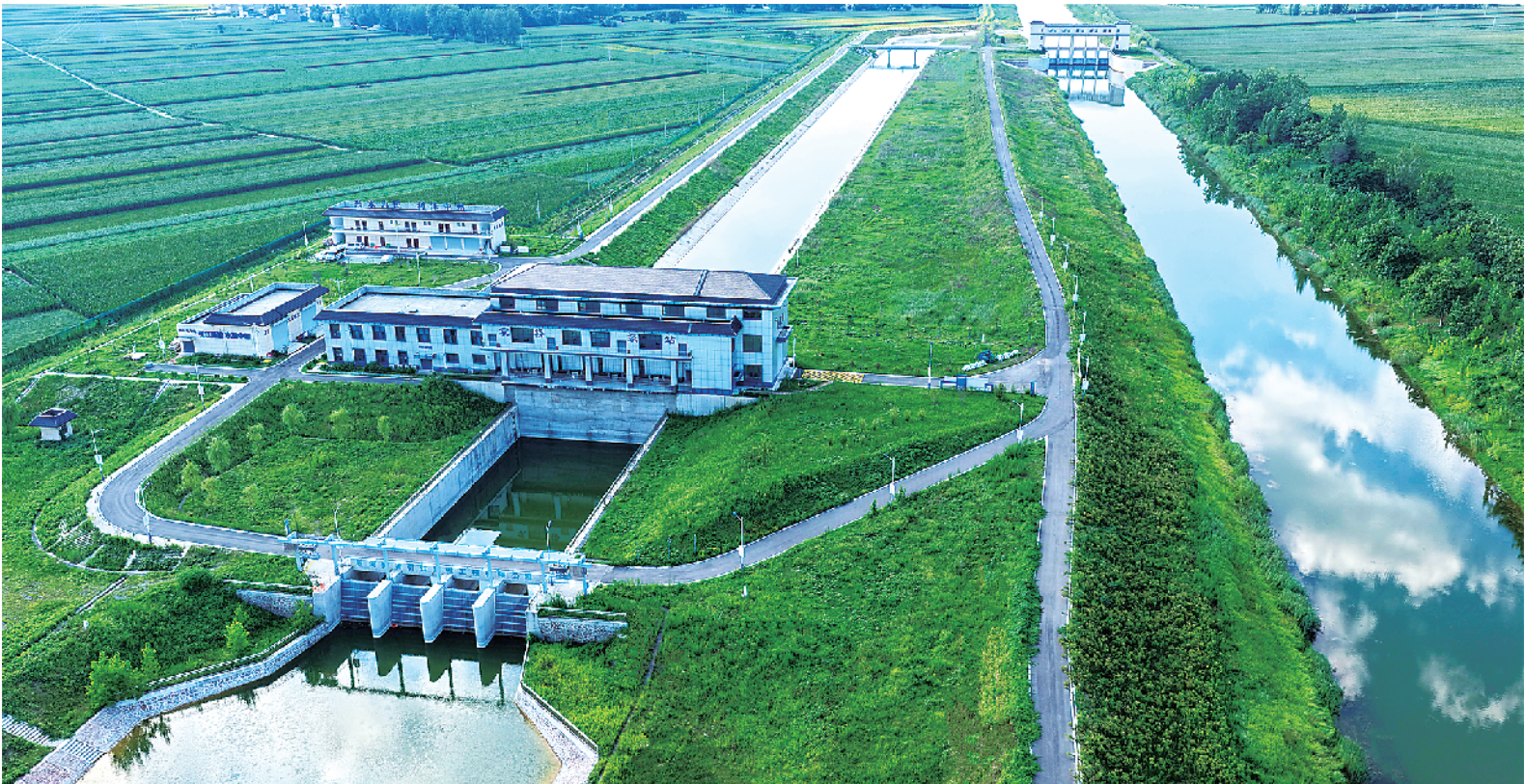
8月26日，“引江济淮”河南源头郸城袁桥泵站水质清澈，四周绿意盎然。
